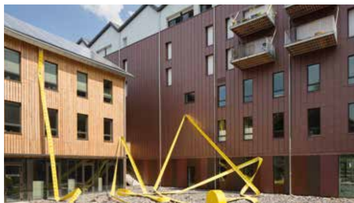
Logements et bureaux ADI, Nantes - Architecte : Essentiel Architecture - Entreprise : Tallot VMZ Joint debout
