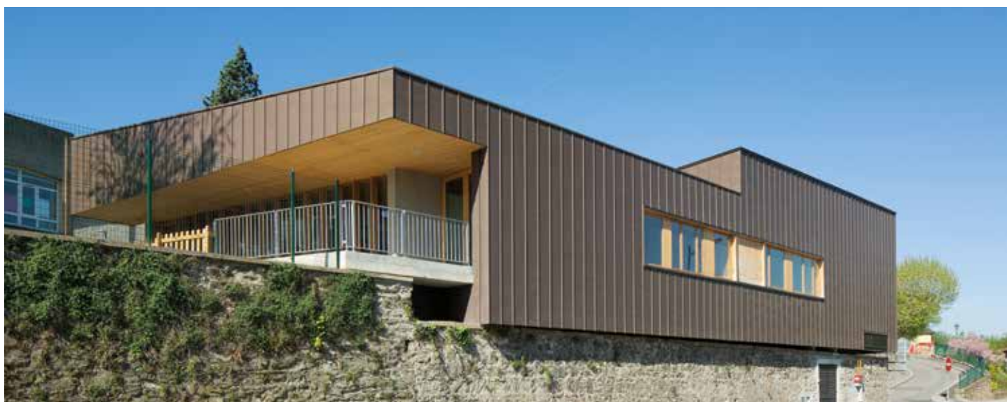
Cantine scolaire, St Romain en Gal (69) - Architecte : Atelier 43 - Entreprise : Saine Franck
