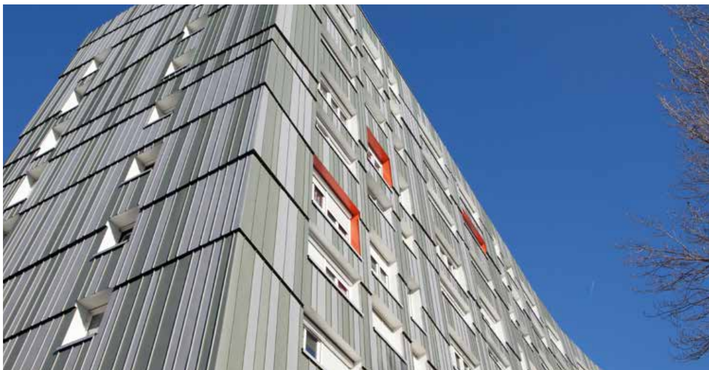
Immeuble Tchécoslovaquie quartier Malakoff, Nantes - Architecte : Agence Nomade - Entreprise : Gautier Entreprise
